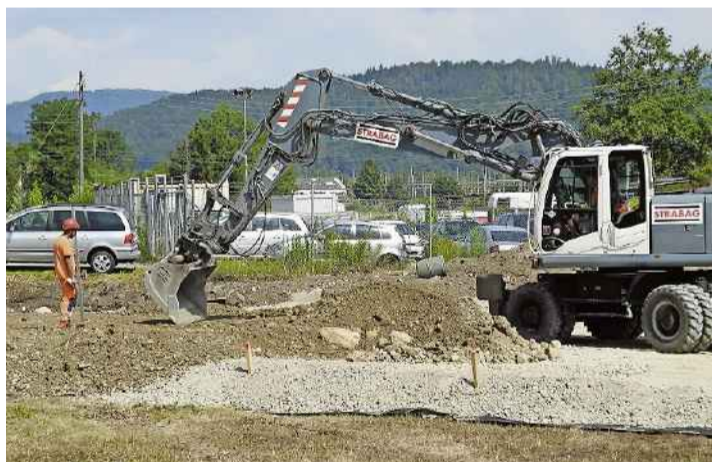
Hier war bis vor kurzem eine Wiese. Nun entsteht ein Installationsplatz für die Limmattalbahn-Baustelle. Bild: mar
